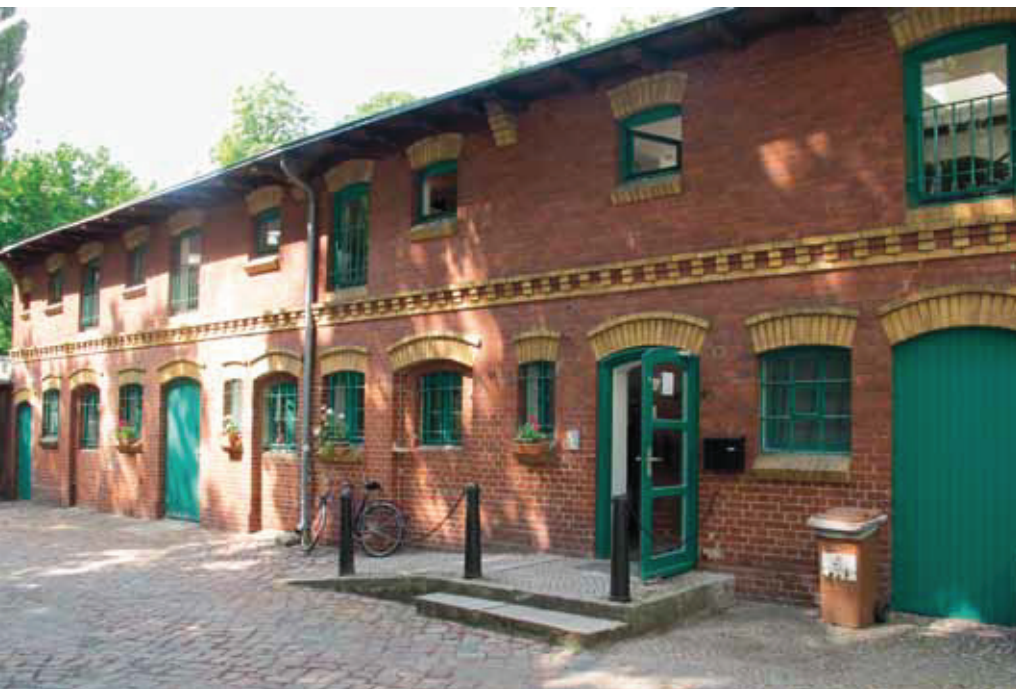
Hofgebäude, Tagesstätte Alt-Reinickendorf der Albatros gGmbH
